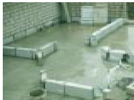
Wärmebrücken-Vermeidung am Mauerfußpunkt durch Porenbeton-Steinreihe (oben) oder mit Puren-Dämmbrücke (unten) am Passiv-Mehrfamilienhaus in Kassel (1999).
