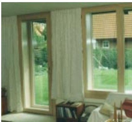
Kastenfenster mit außen Festverglasung und innen zu öffnenden Flügeln im Nullenergie-Haus Adenbüttel (1992).
