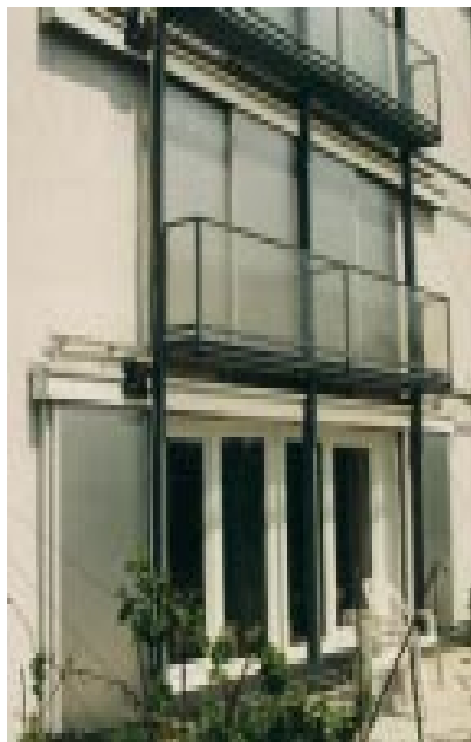
Außenliegende Dämm-Schiebeläden im Passivhaus Darmstadt (1992).
