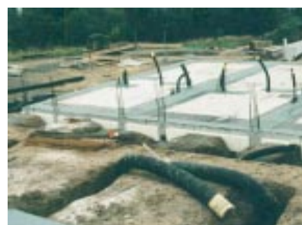
Erdwärmetauscher-Leitungen beim Fundamentbau der Passivhäuser in Stuttgart-Feuerbach (1999)
