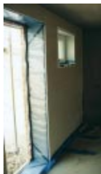
Vorgefertigte Leichtbau-Fassadenelemente vor Gebäudekernen aus Beton-Fertigteilen bei den Passivhäusern in Geisenheim (1997), Wiesbaden (1998) und Hannover (1999).
