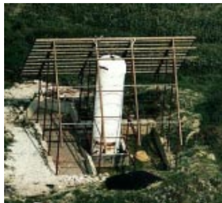
Nullenergie-Haus in Warendorf mit 70 \text{ m}^3 Heizwasserspeicher im Rohbau (1993)
