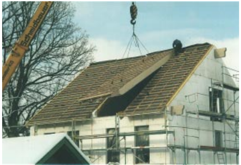
Vorgefertigte 38 cm hohe Dachelemente mit Polystyrol-Dämmkern in 1,5 m Elementbreite im Passivhaus in Marktoberdorf (1998).
