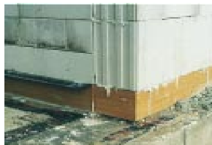
Wärmebrücken-Vermeidung am Mauerfußpunkt durch Porenbeton-Steinreihe (oben) oder mit Puren-Dämmbrücke (unten) am Passiv-Mehrfamilienhaus in Kassel (1999).
