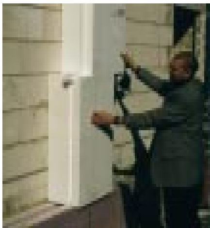
30 cm starkes Wärmedämmverbundsystem mit Nut-Feder-Verbindung beim Passivhaus in Porta Westfalica (1998).
