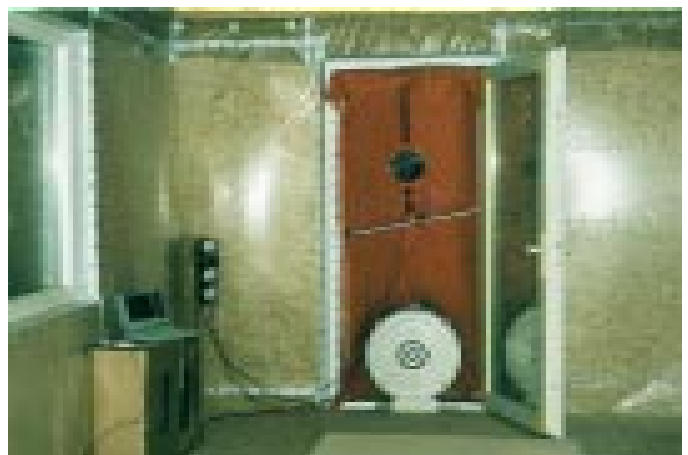
Meßgebläse und stark geblähte innere PE-Folien bei erster Rohbau-Luftdichte-Messung im Passivhaus Detmold (1998).
