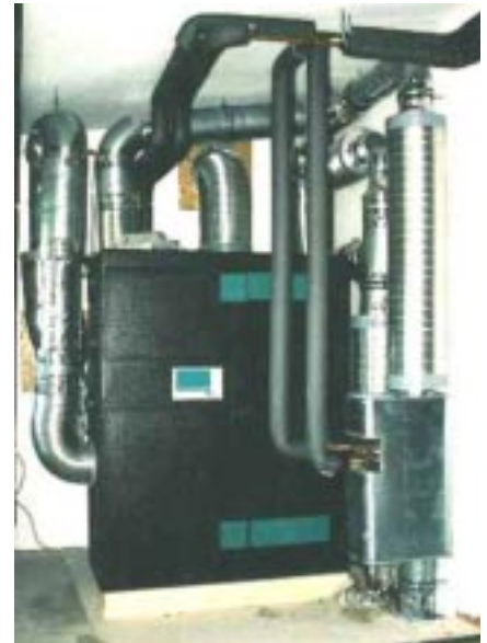
Lüftungsanlage mit besonders hohem Wärmerückgewinnungsgrad für bis zu ca 260 m 3 /h (PAUL)
